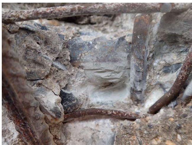
Sonda S7 – podhled 2. N zprava, 1,0 m od OP2 – v trhlině u okraje N (obrázek č. 21)
