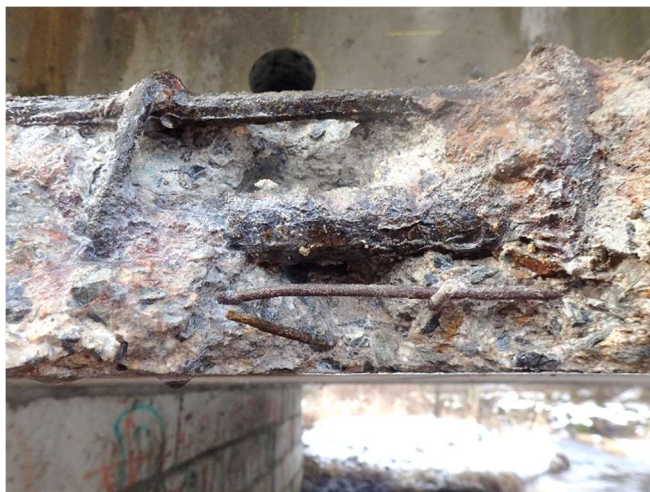
Sonda S6 – bok příruby L krajního N, 2,5 m od konce N nad OP2 – rozpadlá hrana (obrázek č. 20)
